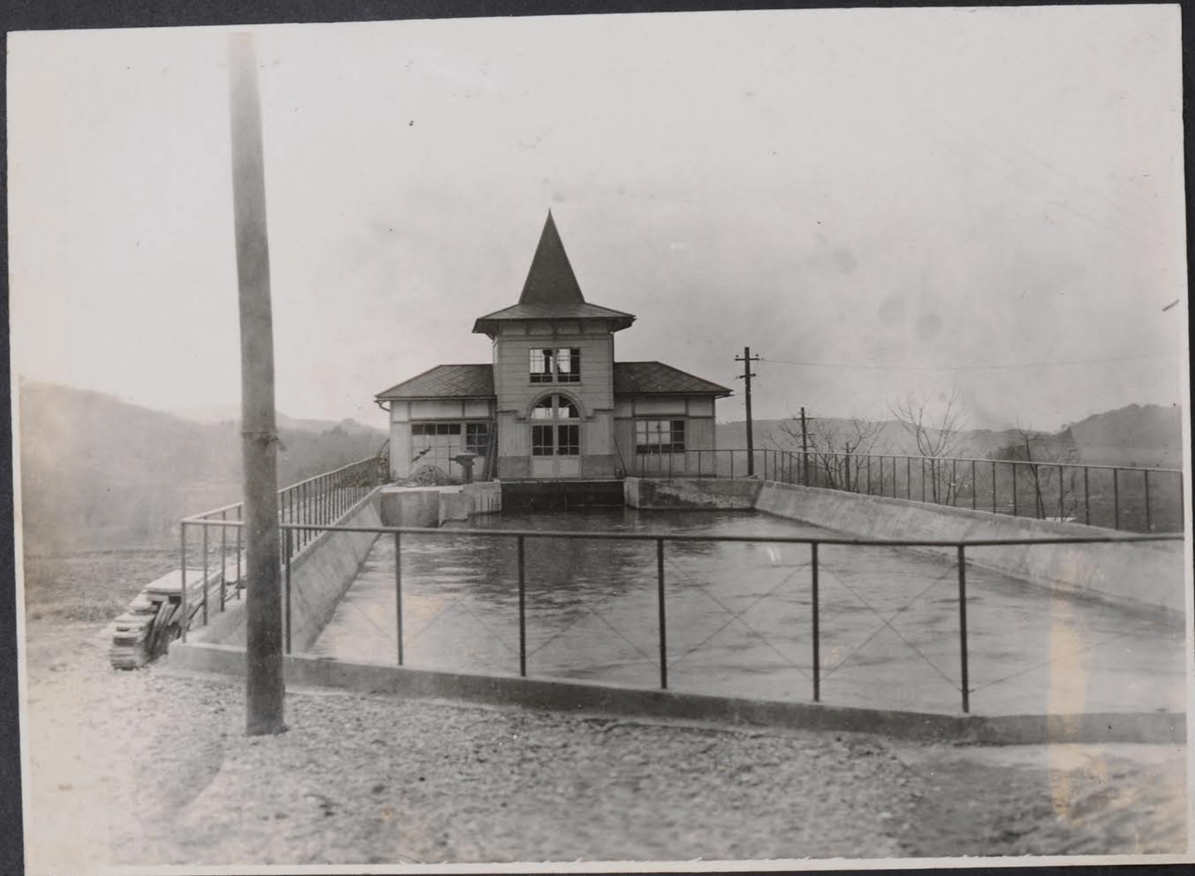
辰巳發電所水槽
