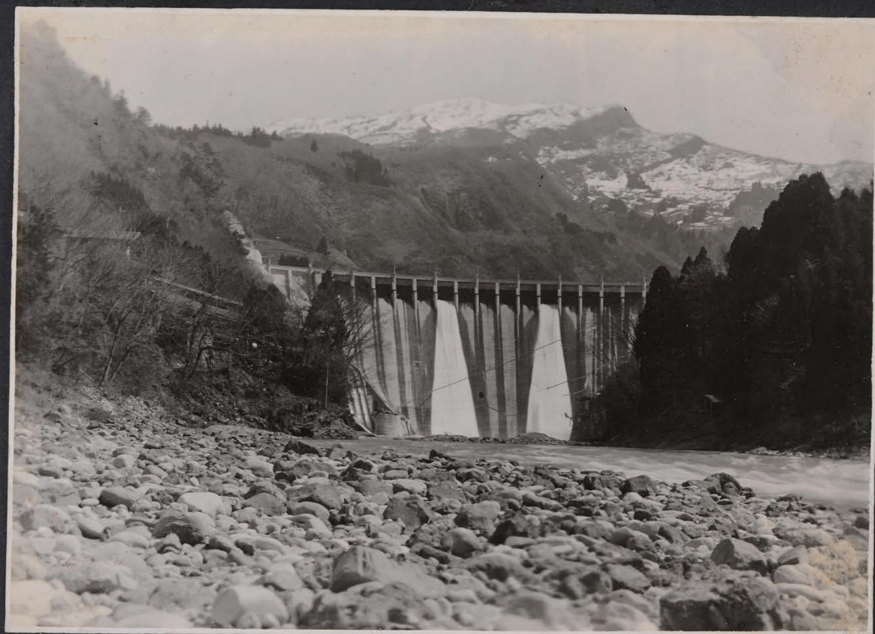
庄川發電所大堰堤
