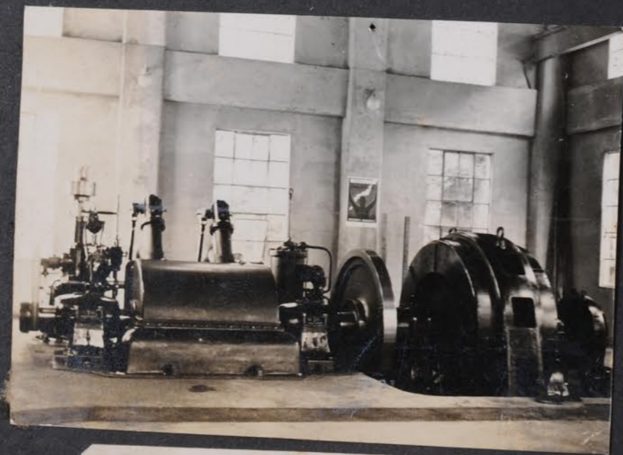
九谷發電所發電機
