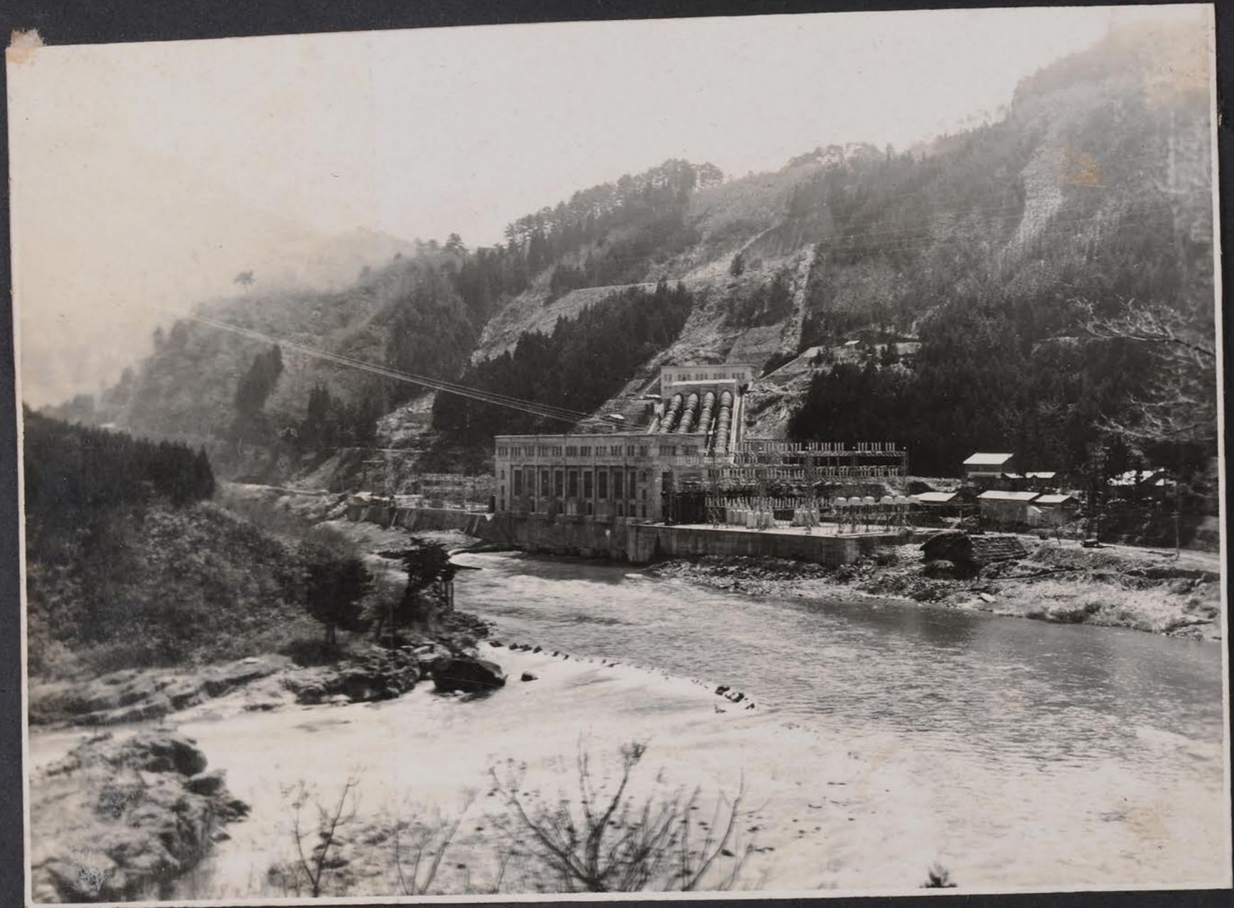
庄川發電所全景
