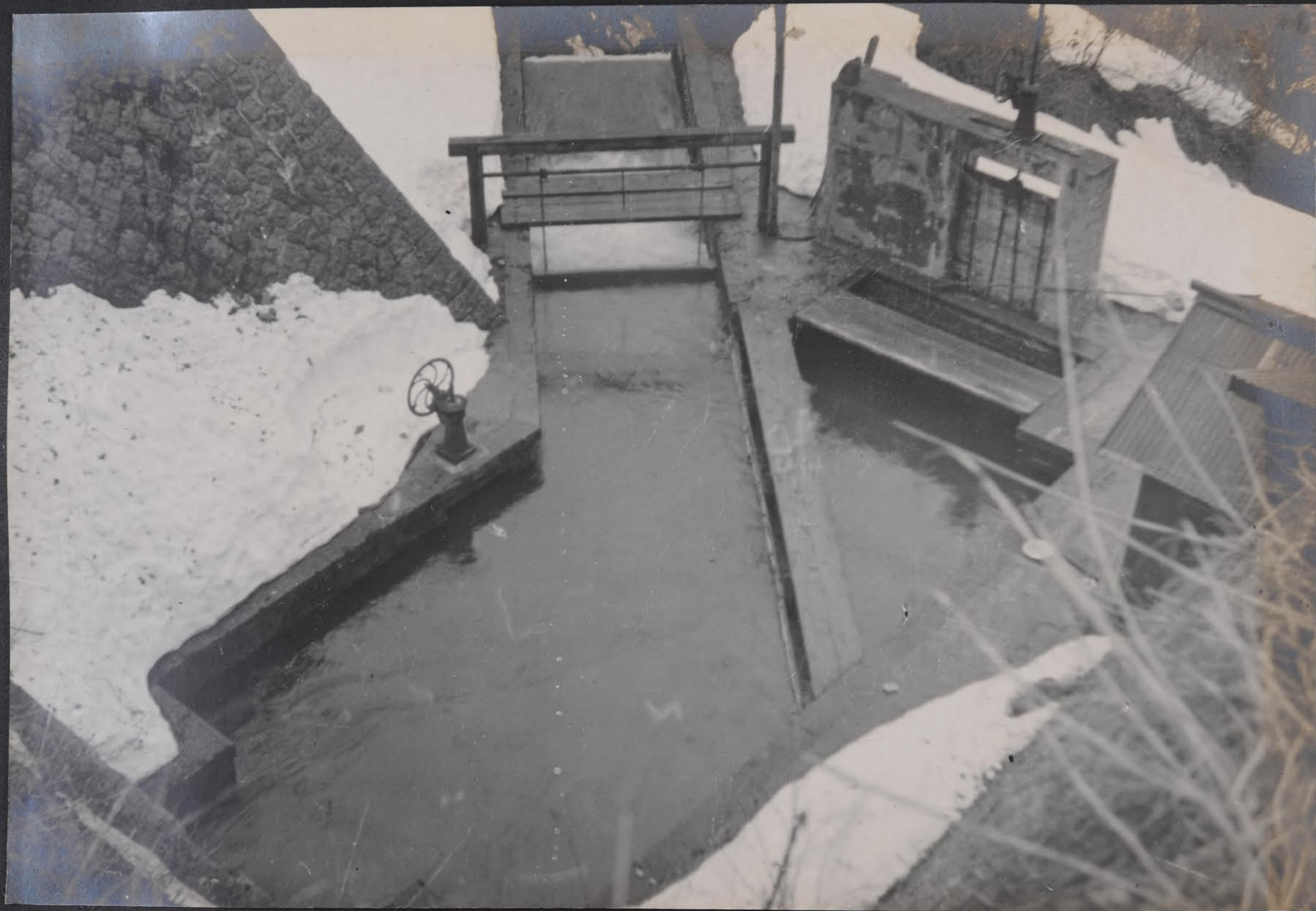
寺津發電所水槽
